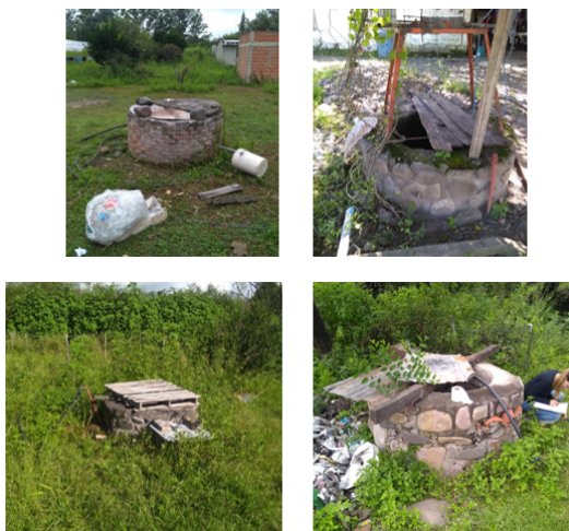
Figura 4 - Estado de construcción y conservación de alguno de los pozos someros de agua de consumo del área de estudio
